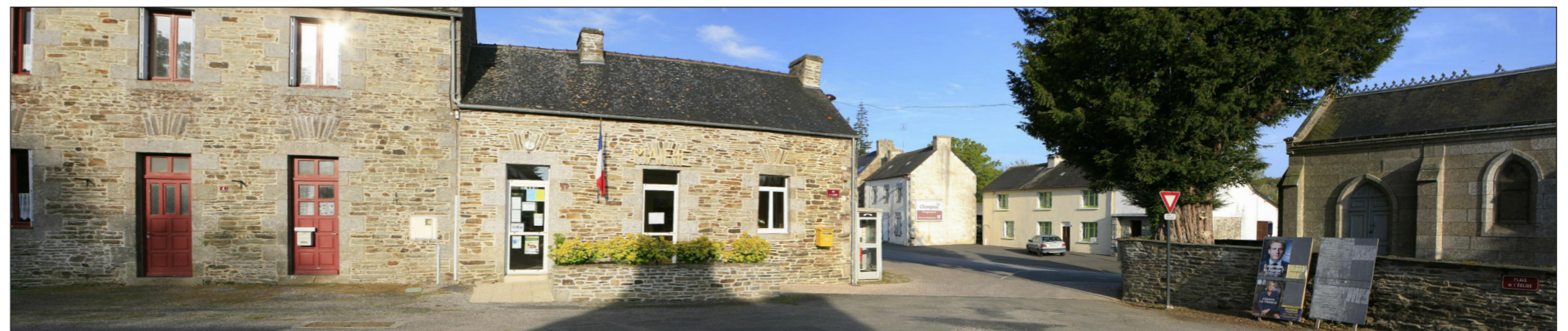
Vue du site avant projet
