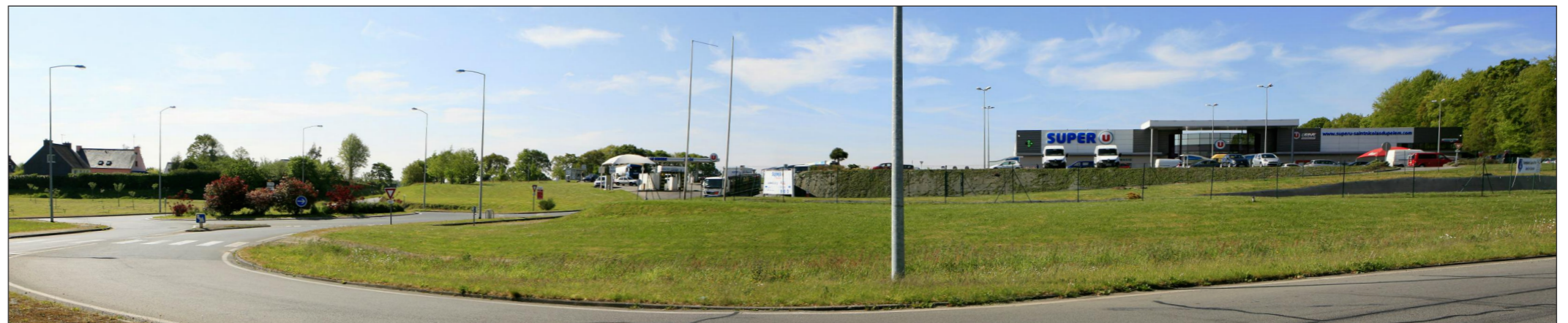
Vue du site avant projet
